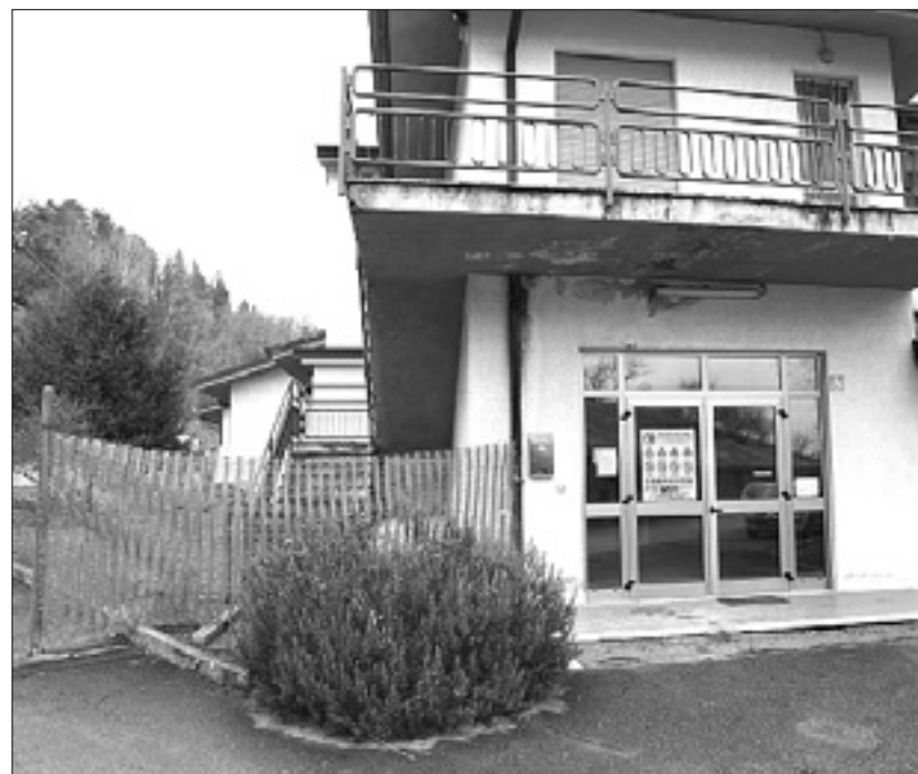
Gradbišče ob šolski stavbi
