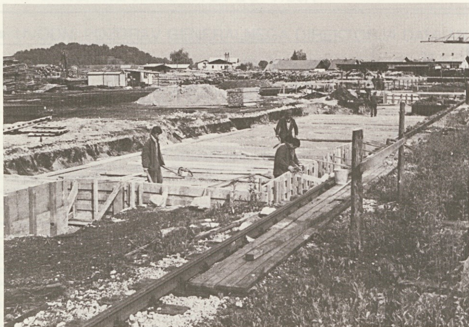
Gradnja temeljev za strojno linijo mehaniziranega skladišča na Žagi Škofljica
