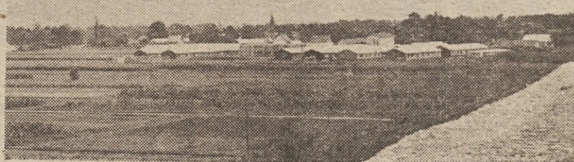
Sredi polja v Forminu se je ugnezdila mala »vasica« delavcev, ki delajo na gradbišču hidroelektrarne
