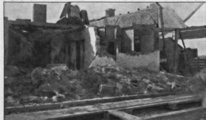
Porušene zgradbe v Brežicah (Iz arhiva F.B.G.-Gegyja)
