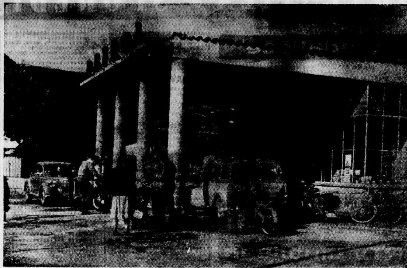
Na novih bencinskih črpalkah postrežejo z vsemi vrstami goriva in maziv, z vodo in zrakov. — Na sliki: Petrolova črpalka v Novi Gorici.
