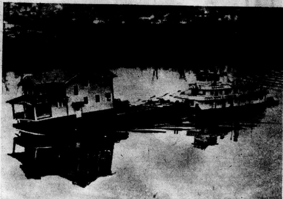
Ob reki Kanawha pri Charlestonu v Zahodni Virginiji bodo razširili avtomobilsko cesto. V ta namen je bilo treba odstraniti štiri stanovaljske hiše: eno izmed njih so izkopali s temelji vred, jo naložili na poseben splav in jo po reki prepeljali nekaj sto metrov daleč
