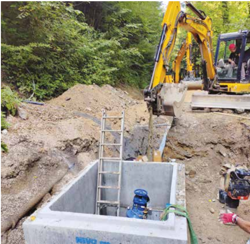
Gradnja tlačnega regulatorja na cesti Matke–vodohran Likovič
