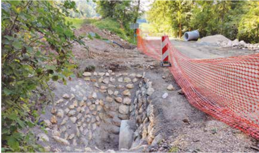
Dela na križišču za vodohran Likovič in Hom
