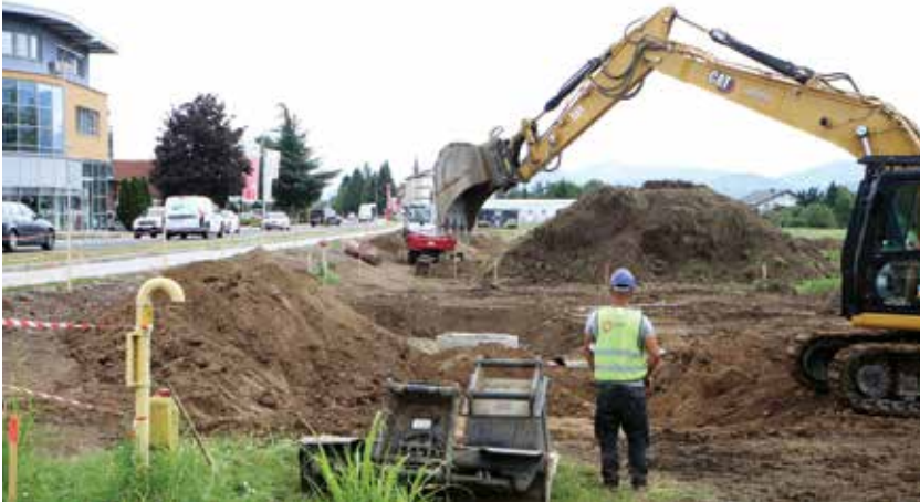
Začela so se dela na težko pričakovanem krožišču v Šempetru.
