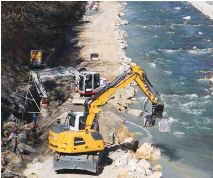
Sanacija desnega brega Savinje od mostu čez Savinjo na Polzeli proti Malim Braslovčam
