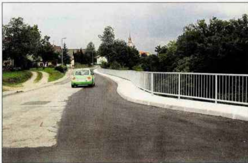
Na Prebačevem so zgradili oporni zid, pločnik in postavili zaščitno ograjo.
