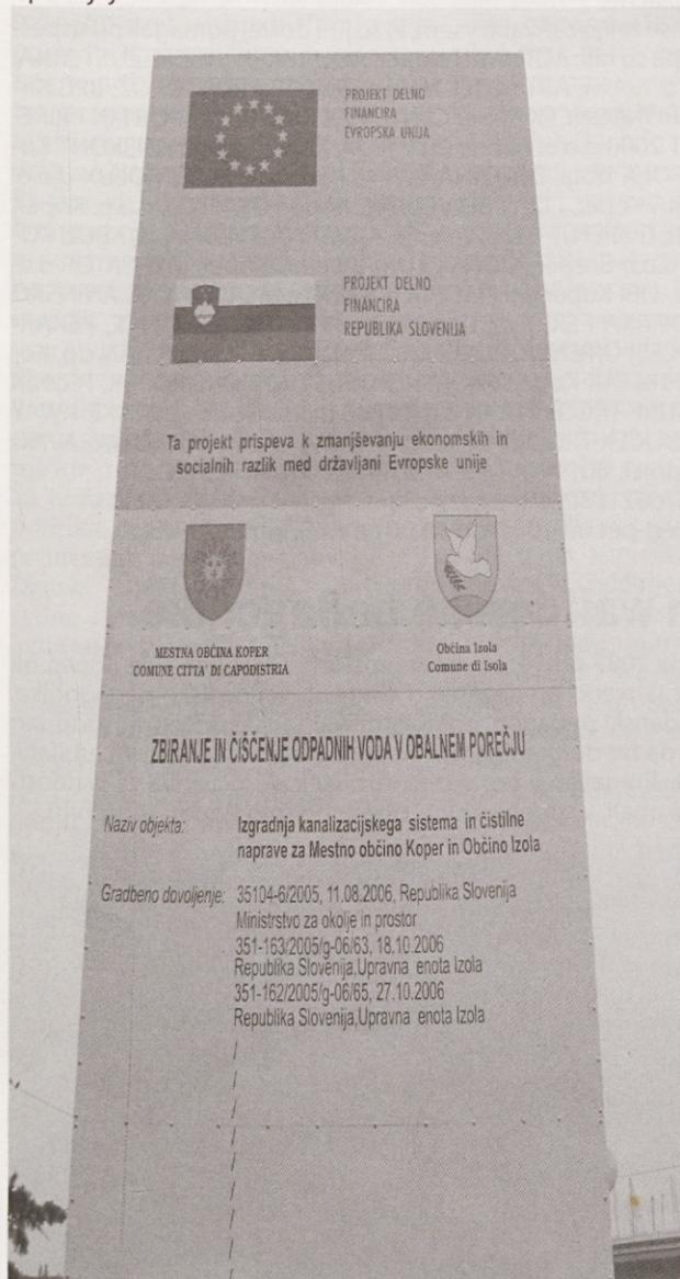
Začetek gradnje čistilne naprave
