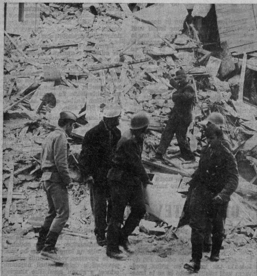
CIVILNA ZAŠČITA PRI REŠEVANJU MATERIALNIH DOBRIN IZPOD RUŠEVIN
