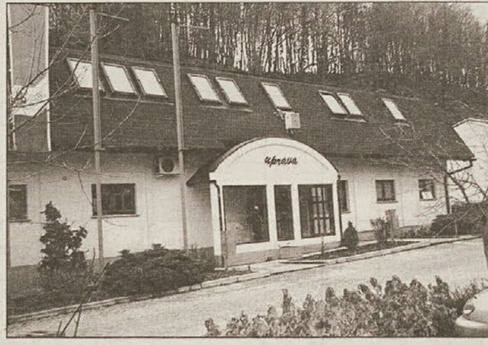
Upravna zgradba Kostaka
