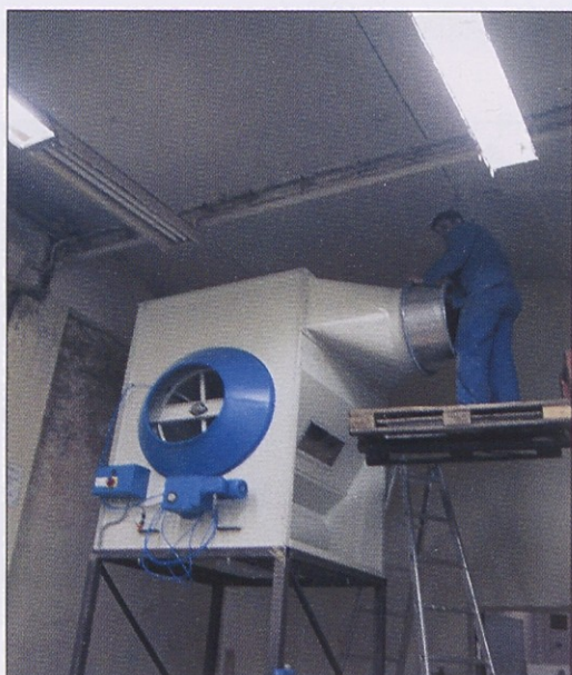
Montaža filtra Luwa
