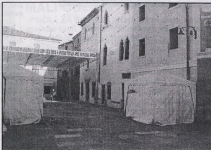
E il Palazzo è ancora lì...
