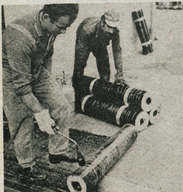
Lepljenje IZOTEKT — bitumenskega varilnega traku na preklapu
