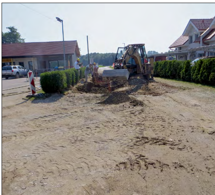
Izgradnja kanalizacije na odseku Skorba, pri domu krajanov
