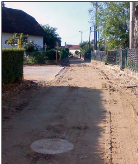
Zaključna kanalizacijska dela na odseku Zg. Hajdina
