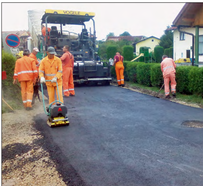
Zaključna dela in asfaltiranje v Skorbi
