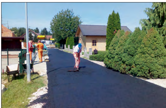
Zaključek kanalizacijskih del in asfaltiranje v naselju Gerečja vas
