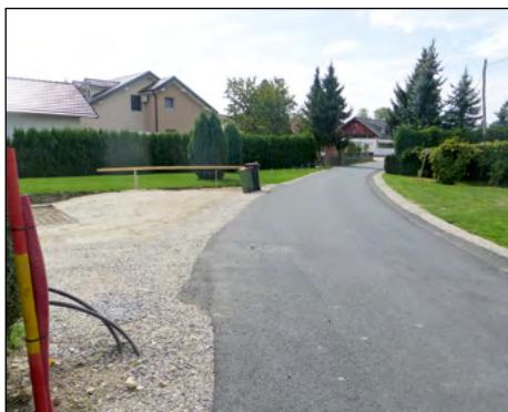
Zaključek kanalizacijskih del v naselju Hajdoše
