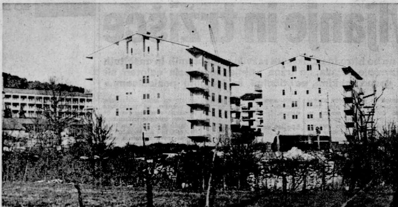
SEŽANA SE MODERNIZIRA — V bližini bolnišnice Ivana Regenta v Sežani je zraslo nekaj stolpčev (na sliki), ki bodo z 80 stanovanji delno rešili stanovanjsko stisko. V tem delu mesta nameravajo zgraditi tudi otroški vrtec. Zaradi hitre ceste proti Italiji, ki bi morala čez hrib Tabor v bližini bolnišnice, ima investitor, Kraški zidar, z nadaljnjo gradnjo nekoliko pomislekov.
