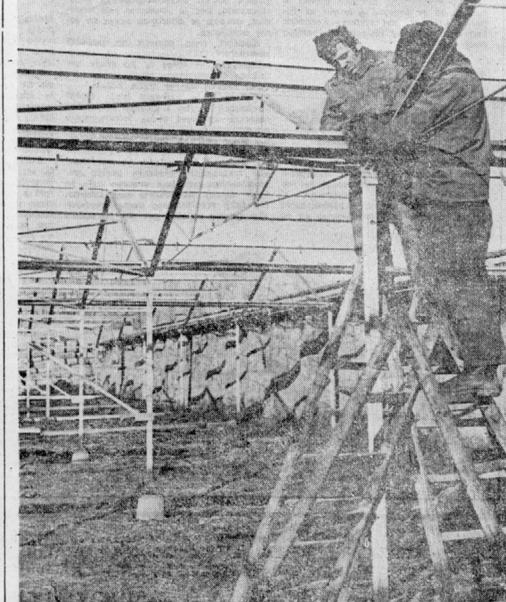
SE 6.200 KVADRATNIH METROV POD STEKLOM — Cez dober mesec bodo toliko površine spet zasteklili na Čatezu. Nov rastlinjak pravkar postavljajo. Z njim vred bo pod streho 32 tisoč kvadratnih metrov vrta. Lani so natrgali na Čatezu tri in pol milijona nagelnjovih cvetov. Kmalu pa bodo navrtali še nove vrtnice za termalno vodo.
