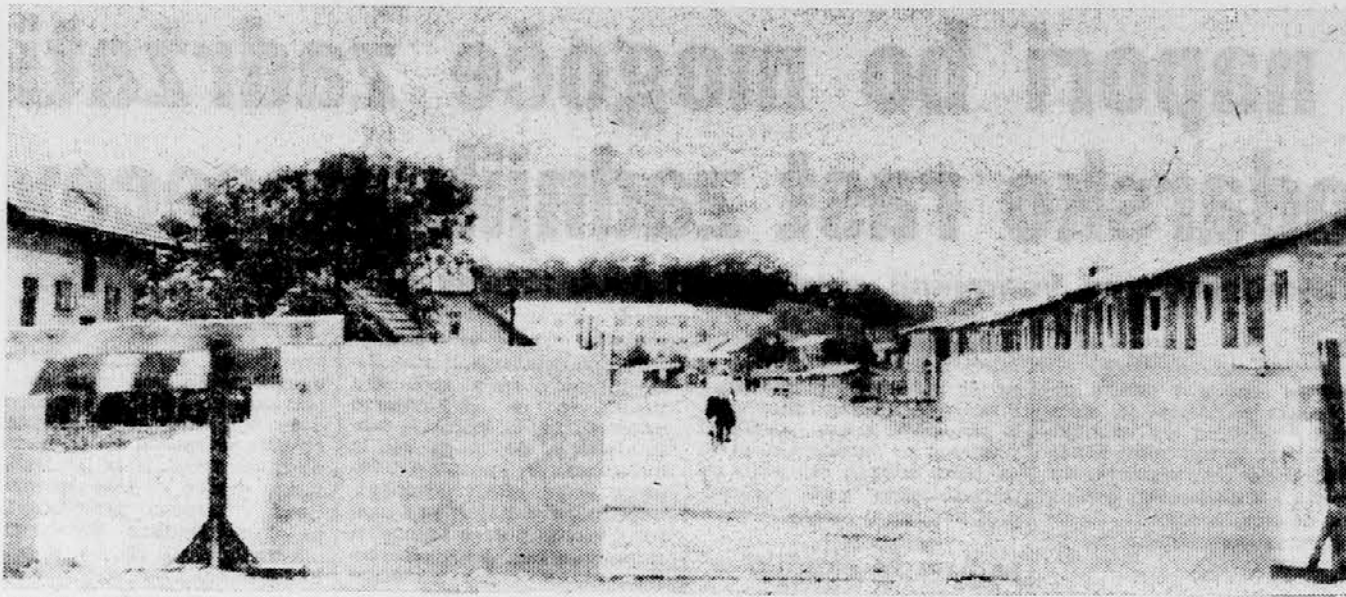
NOVA ULICA NA HUDINJI — V nastajajoči soseski na Hudinji pri Celju, bodo končali urejevanje nekaterih ulic. Vse kaže, da smo tudi v Celju že tako daleč, da uspevamo urediti nekatere komunalne naprave prej, preden se v stanovanje vselijo stanovanjci. Ulica na naši sliki ni prva, ki bo urejena še pred vselitvijo stanovanj. Foto: B. Strmčnik
