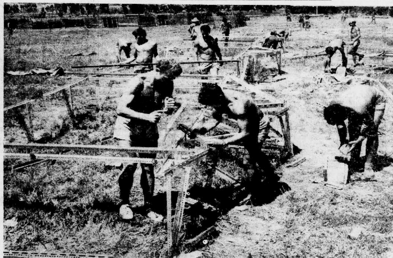
BRIGADIRJI SESTAVLJAJO OGRODJE ZA MONTAŽNE HIŠE — V naselju Djorče Petrov že stoje nekaj montažnih hiš, treba pa jih bo zgraditi še veliko. Sestavljanje ogradij za montažne hiše ni težko delo, zahteva pa precej natančnosti. Treba je vrtati luknje in napak ni mogoče popravljati. Pri tem delo pomagajo našim brigadirjem tudi strokovnjaki iz inozemstva, predvsem iz Nemške demokratične republike. Foto: Petrović
