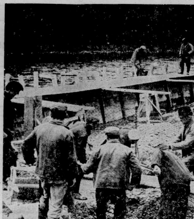
RADGONA BO VARNA PRED MURO — Na našem bregu Mure pri Gornji Radgoni so začeli graditi betonske zidove, ki bodo letošnje zavarovali to mesto pred poplavam. Znatno zahtevnejša dela čakajo Avstrijci, saj bodo trajala najmanj tri leta. Sele tedaj bo Mura tudi zares ukroćena.
