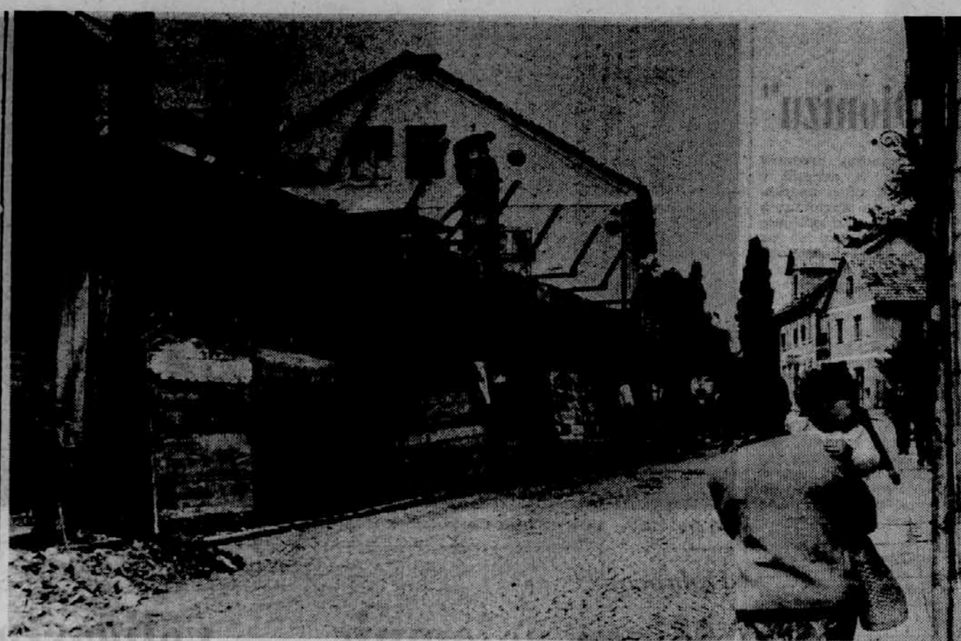
V CRNOMLJU GRADILJO BLAGOVNICO — Podjetje Dolenjka iz Novega mesta gradi na Kolodvorski cesti v Crnomlju novo trgovsko hišo na kraju, kjer je več let zevala škribina porušene hiše in kazila viden mesta. Dela v izvedbi domačega podjetja Begrad lepo napredujejo. Kaže, da bo še pred koncem letošnjega leta trgovina začela posloovati. Foto: R. Bačar
