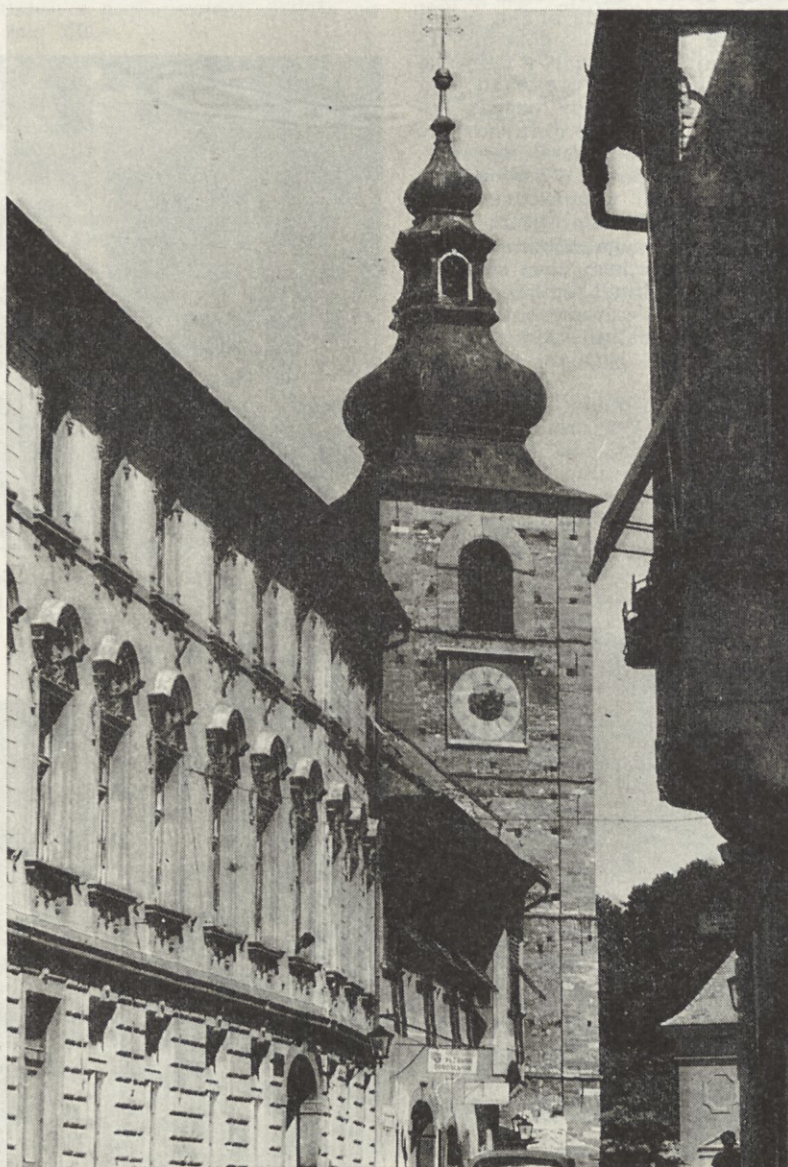
Vzdrževanje starih zgradb v starem delu Ptuja je zelo drago, stanovanja pa so še vedno neprimerna in nefunkcionalna
