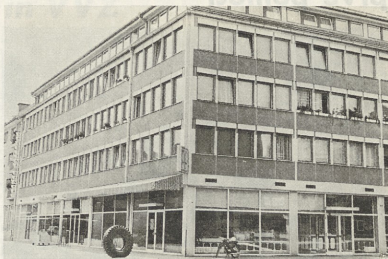
Po vojni je Ptuj dobil približno 30 večjih stanovanjskih zgradb, stanovanja v njih pa ne zadoščajo niti za naravni prirastek prebivalstva
