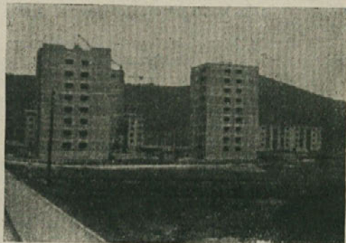
Posnetek z gradbišča »Beton« Velenje
