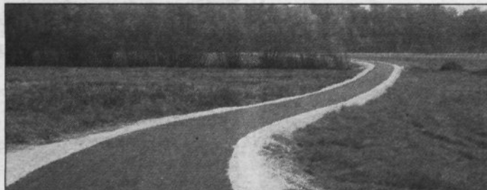
Sanacija odseka Veliko Mraševo - Gazice - V tem času je Občina Krško zaključila z modernizacijo odseka Veliko Mraševo - Gazice. Investicija je občino Krško stala 10 milijonov tolarjev, ostala finančna sredstva do asfaltne prevleke pa so zagotovili krajanji in Krajevna skupnost Podbočje.
