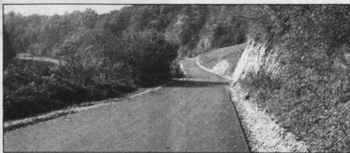
Anže - Graben - Pomemben niz v povezavi med Brestanico in Koprivnico predstavlja tudi moderniziran odsek Anže-Graben v dolžini 800 m in vrednosti 12 milijonov tolarjev.
