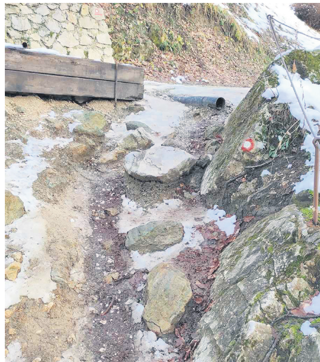
Del poti na Celjsko kočo. Vidi se cev odvodnjavanja, ki je speljana kar na pot, kjer je zaradi tega vse manj zemlje in so skale vse bolj gole. (Foto: IT)
