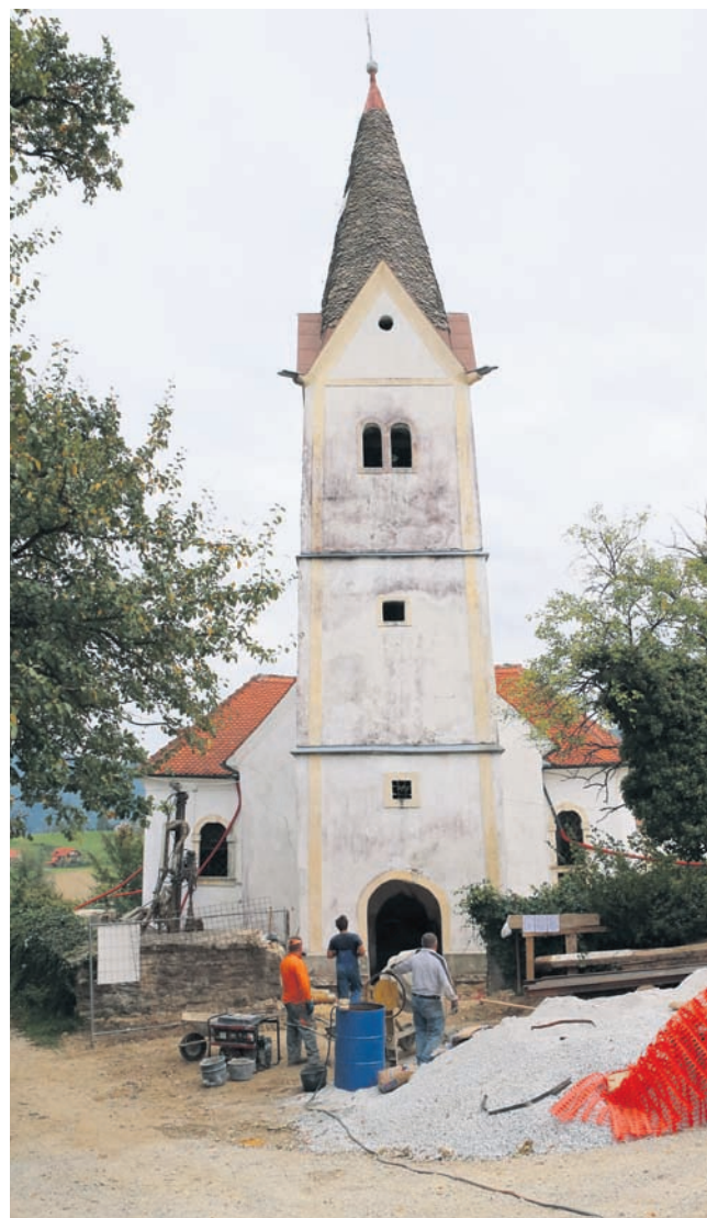
Zvonik cerkvice sv. Janeza bo za vedno ostal nagnjen. Če ne bi temeljito posegli v temelje, bi se najkasneje v dveh desetletjih porušil v cerkveno ladjo.
