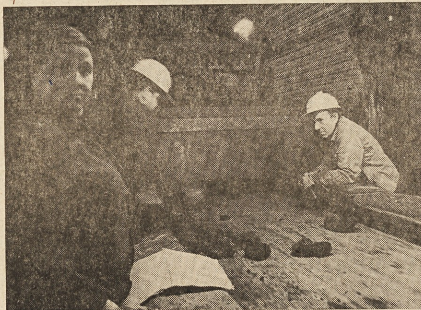
Drobilnica premoga na Separaciji v Trbovljah. Pred drobljenjem je treba izločiti kamenje, drva, kose železa, itd.
