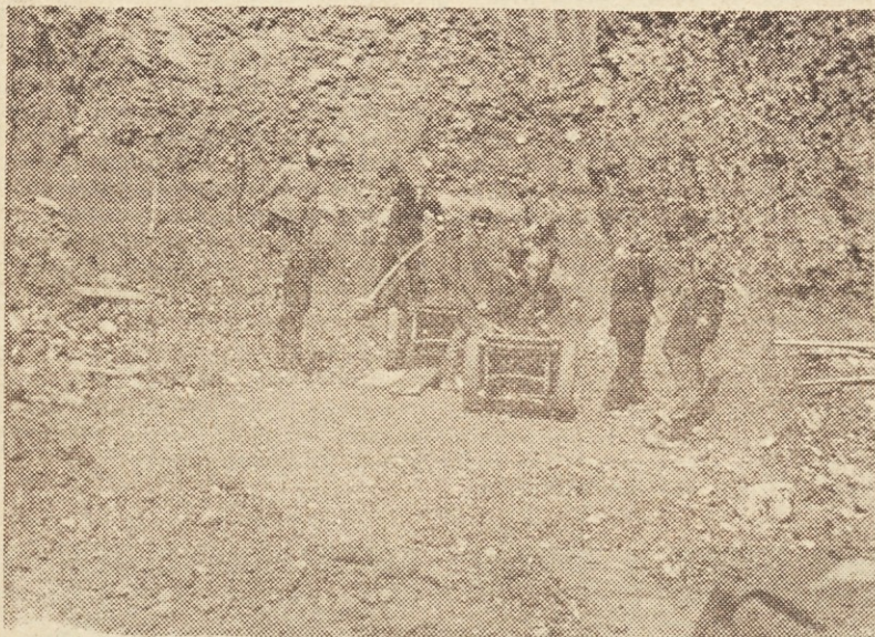
Delavci kopljejo in odvažajo material iz podnožja navpičnih gramoznih sten, višine ca. 10 metrov
