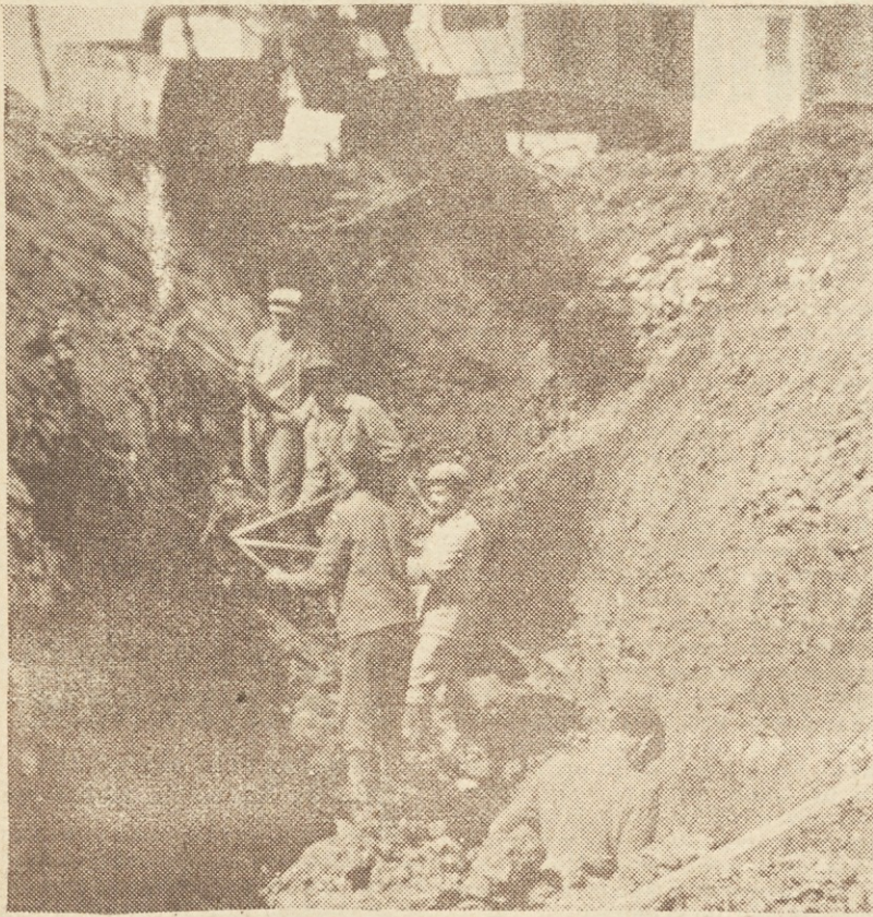
Izpodkovavanje stene jarka
