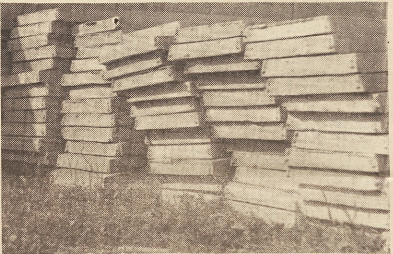
Nepravilno razkladanje prednapetih plošč
