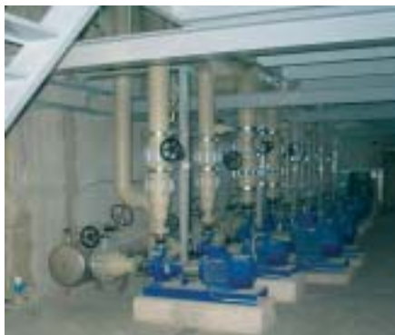
Rezervoarji in črpališče filtrirane vode
