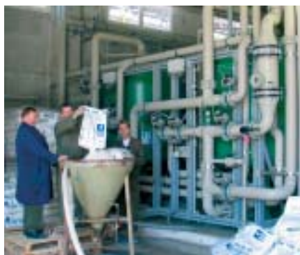
Prvo polnjenje demi kolon z ionsko maso
