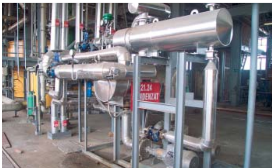
Toplotna postaja za koriščenje odpadne toplote
