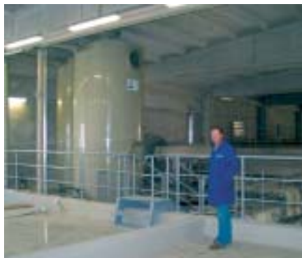
Odplinjevalniki CO_2 po procesu dekarbonatizacije
