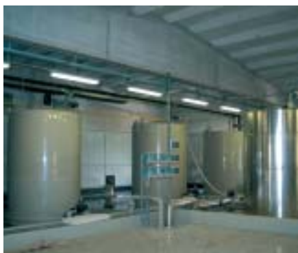
Skladišni rezervoarji za 50%NaOH in 33% H_2SO_4
