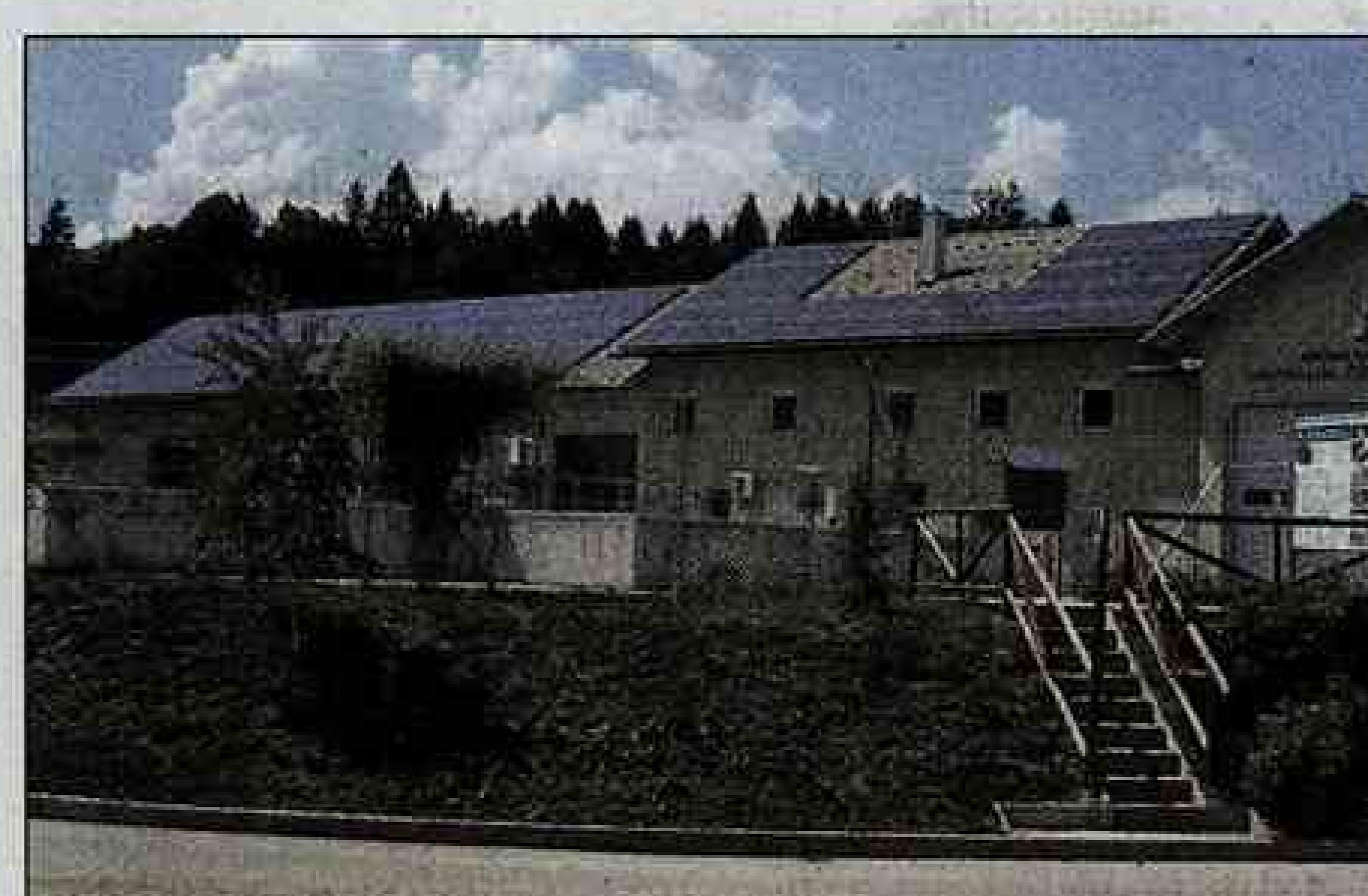
Na strehah dveh objektov Centralne čistilne naprave, ki imata primerno lego za izkorisčanje sončne energije ter ustrezeno kritino, je nameščenih 452 solarnih modulov.
