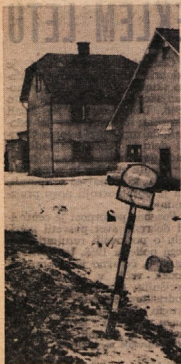
Trojni pomen prometnega znaka: obvezno tehtanje, vozi previdno, sicer boš zletel s ceste in malomarnost pa taka. (Znak je namreč že precej časa zviti, ni se pa še nihče našel, ki bi ga poravnal ali pa to na ustreznem mestu naročil.)
