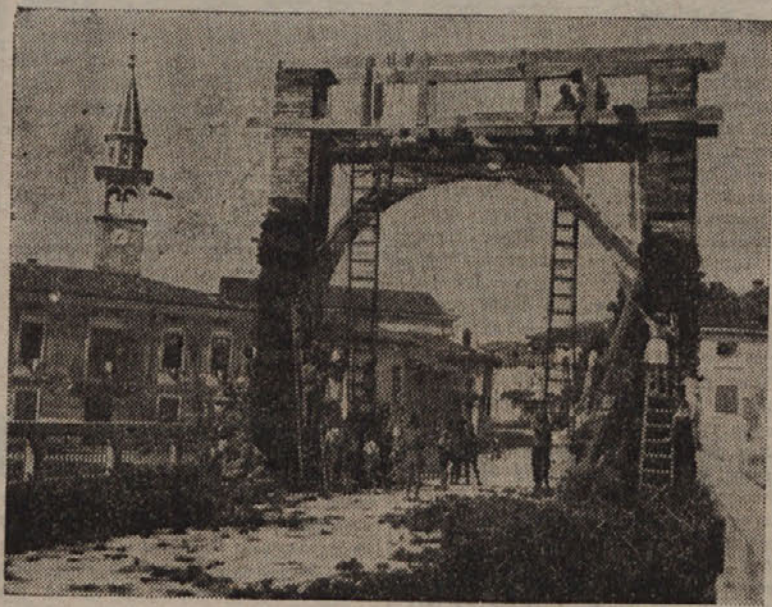
SLAVOLOK BO KMALU DOKONČAN
