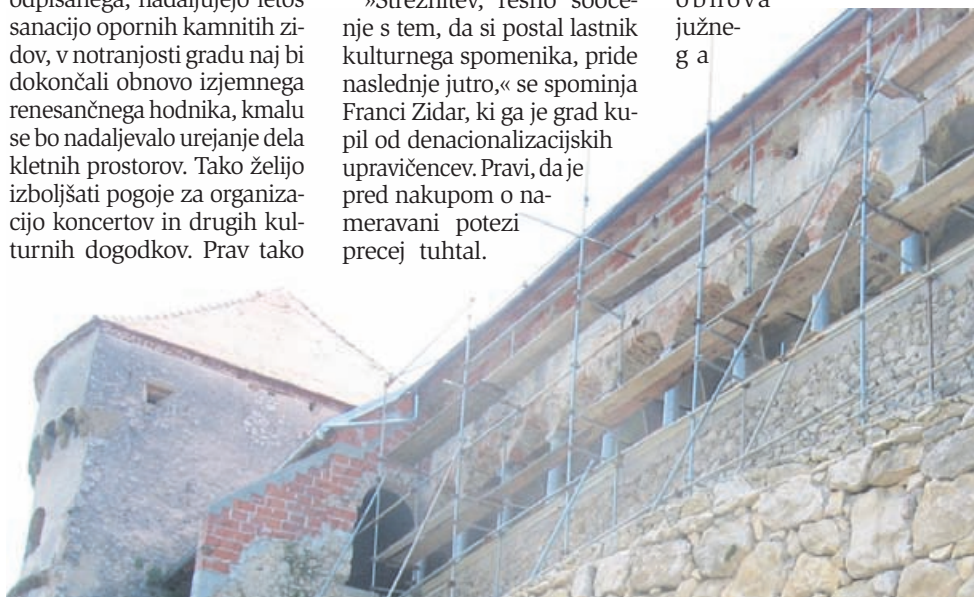
Izjemen renesančni hodnik nekoč odpisanega gradu naj bi bil dokončno obnovljen še letos.
