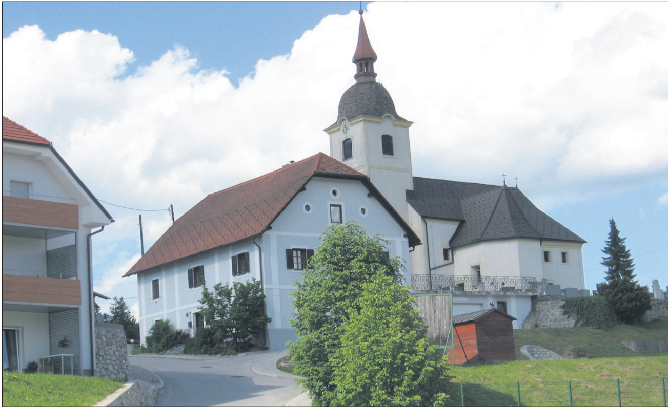
Pogled na cerkev in župnišče v Kompolah pri Štorah. V kraju so se že nekaj časa bali, da bo lepo urejeno župnišče ostalo brez stalnega župnika. Tudi med večino ljudi, ki verskih obredov ne obiskujejo, velja, da ima kraj s stalnim duhovnikom večjo veljavo.
