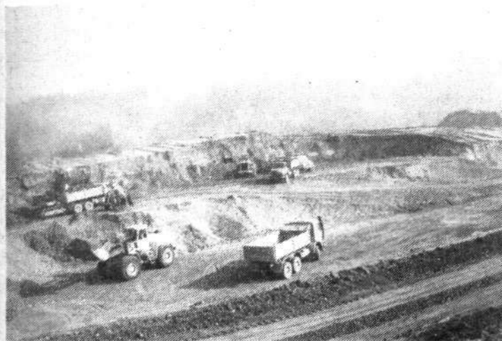
Gradbišče HE Vrhovo v začetku del.
