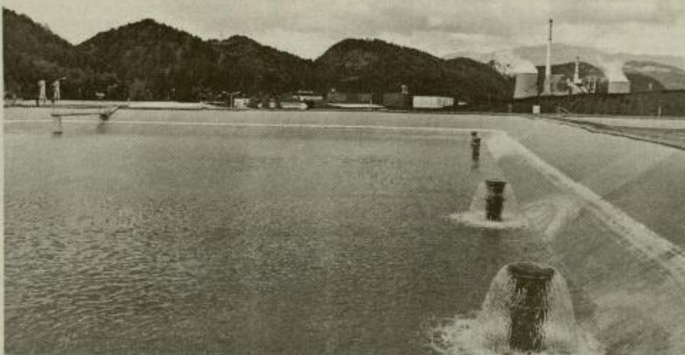
Kakovost šaleških voda se je zaradi izvedenih sanacijskih ukrepov v podjetjih že bistveno izboljšala. V šoštanski termoelektrarni so na primer poskrbeli za ureditev zaprtega krogotoka transportne vode za pepel.
