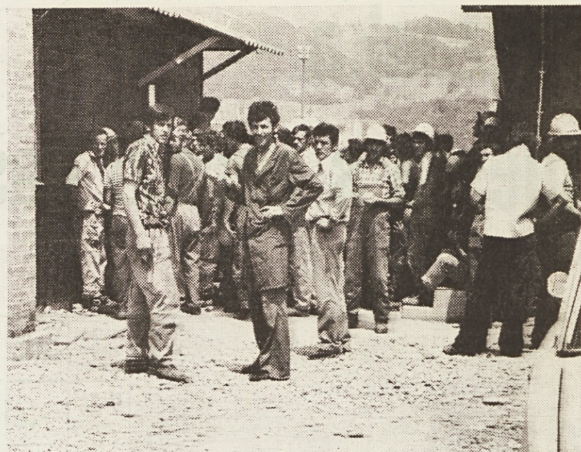
Tako so na gradbišču v Krškem vpisovali posojilo za ceste
