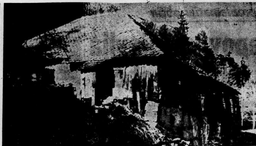
PRENOČEVANJE V STARI ŽAGI — Staro vodno žago bodo v kratkem adaptirali in v njej uredili nekaj prenočišč. Pozneje nameravajo stavbo povsem prenoviti v sodoben gostinski objekt.
