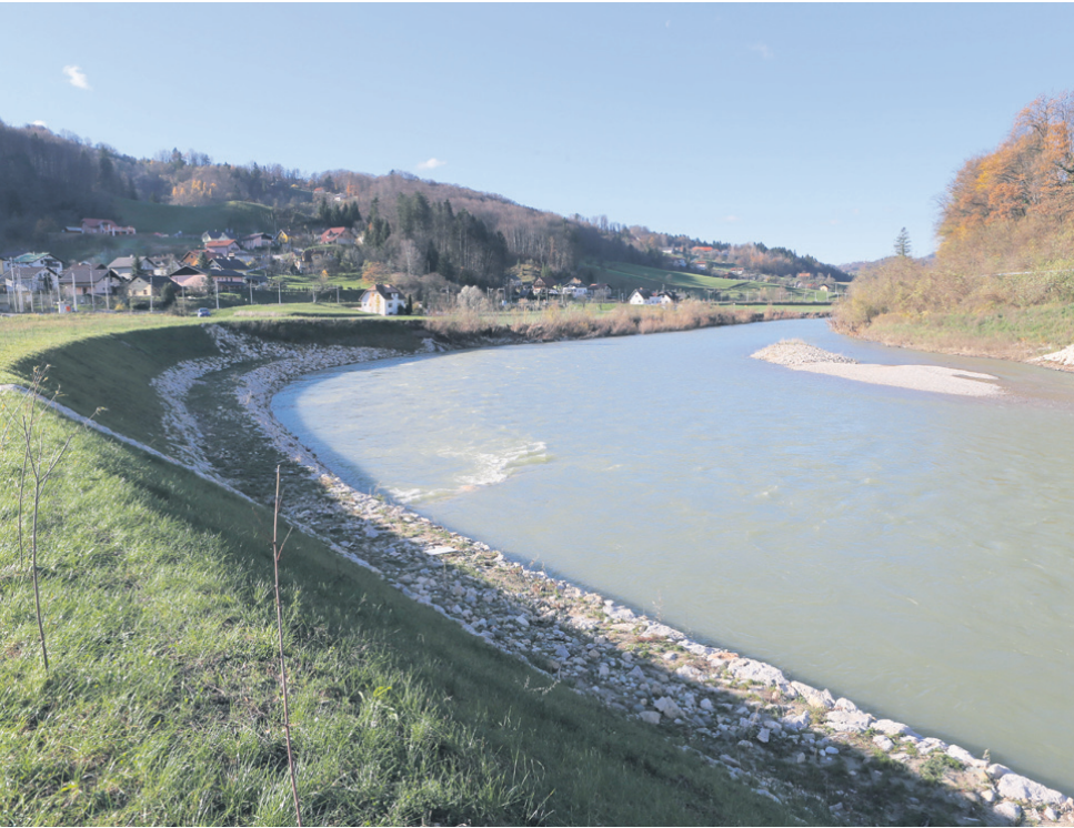
Ob visokih vodah se Savinja po novem z veliko hitrostjo razlije naravnost proti hišam. Tudi prejšnji konec tedna se je voda razlila in dosegla cesto pri hišah. Lani je prišla do vrha škarpe ob hiši, ki je visoka 1,7 metra.
