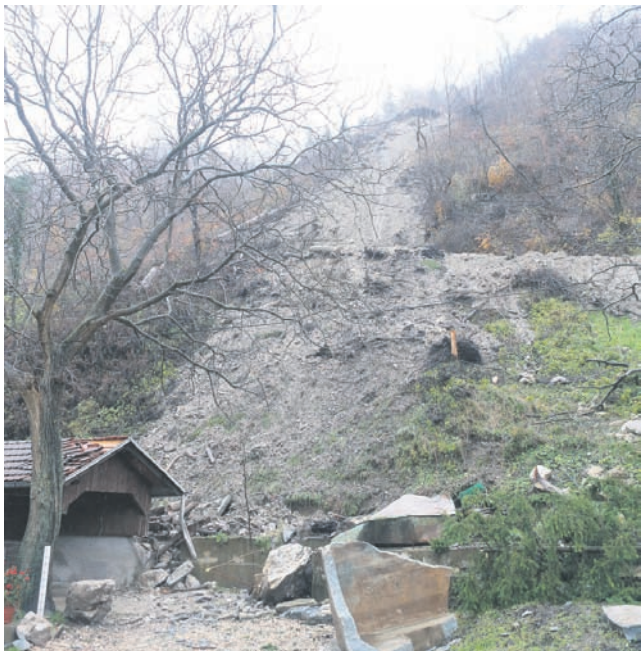
Plaz je odnesel tudi vodni rezervoar sosednje hiše (na sredini spodaj).
