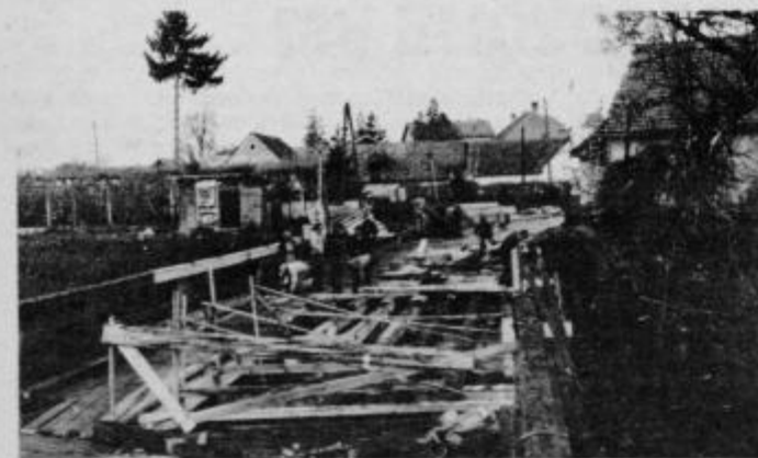
Dela na mostu so v polnem teku
