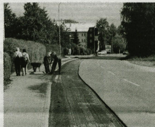
Te dni so popravili lani nepravilno položeno asfaltno prevleko nad glavnim plinskim vodom vzdolž Ljubljanske ceste na Duplici (F. S.)
