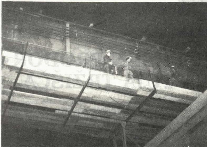
Za varno delo je bilo poskrbljeno (montažni odri na žerjavnih progah)
