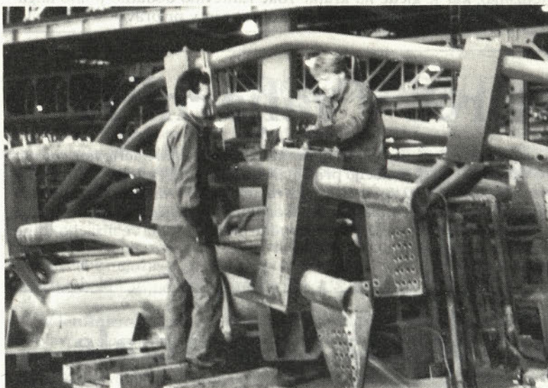
Remont Jeklarni 1989 – demontirani jakotočni nosilci EOP 2 na tehničnem pregledu in popravilu v hali vzdrževanja
