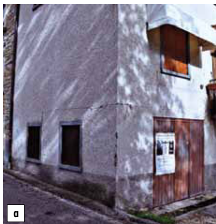
Slika 9 • Zdrs med zidom in stropno konstrukcijo (a), poškodbe različnih tipov (b) in stavba z vodoravnimi vezmi, ki je preživela potres (c).
