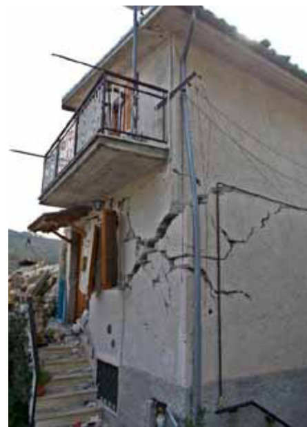
Slika 6 • Značilne diagonalne strižne razpoke v pritličju.
