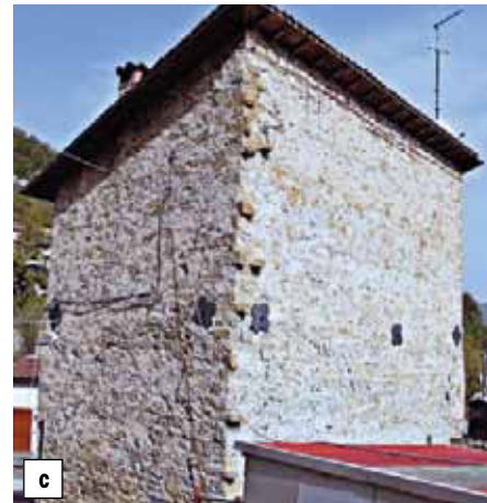
Slika 9 • Zdrs med zidom in stropno konstrukcijo (a), poškodbe različnih tipov (b) in stavba z vodoravnimi vezmi, ki je preživela potres (c).
