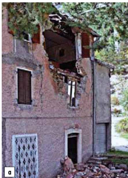
Slika 8 • Izpad zidu iz lastne ravnine (a), pojav navpičnih razpok (b) ter izguba stabilnosti in ločevanje zidov (c).
