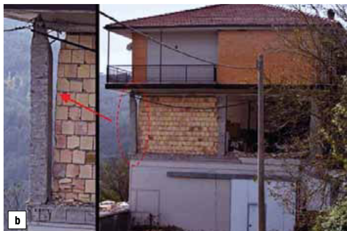
Slika 12 • Armiranobetonska konstrukcija pred potresom 24. 8. 2016 (a) (Google Maps, 2016) in po njem (b).
