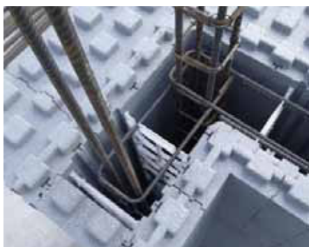
Slika 6 • Minimalno armiranje velikih šibko armiranih sten.
