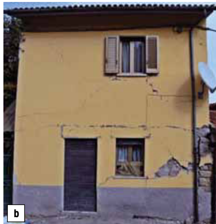
Slika 9 • Zdrs med zidom in stropno konstrukcijo (a), poškodbe različnih tipov (b) in stavba z vodoravnimi vezmi, ki je preživela potres (c).
