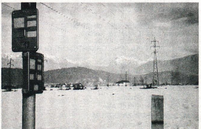
NESREČNA TRINAJSTICA? morda je za sedanji »tempo« priprav na izgradnjo plinovodnega omrežja nekoliko kriva tudi oznaka osamljenega razvodnega ventila na glavnem plinovodu sredi podgorskega polja, ki nosi številko 13. (fs)
