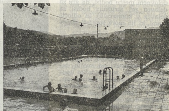
V ospredju stari bazen, v ozadju gradbišče novega bazena
