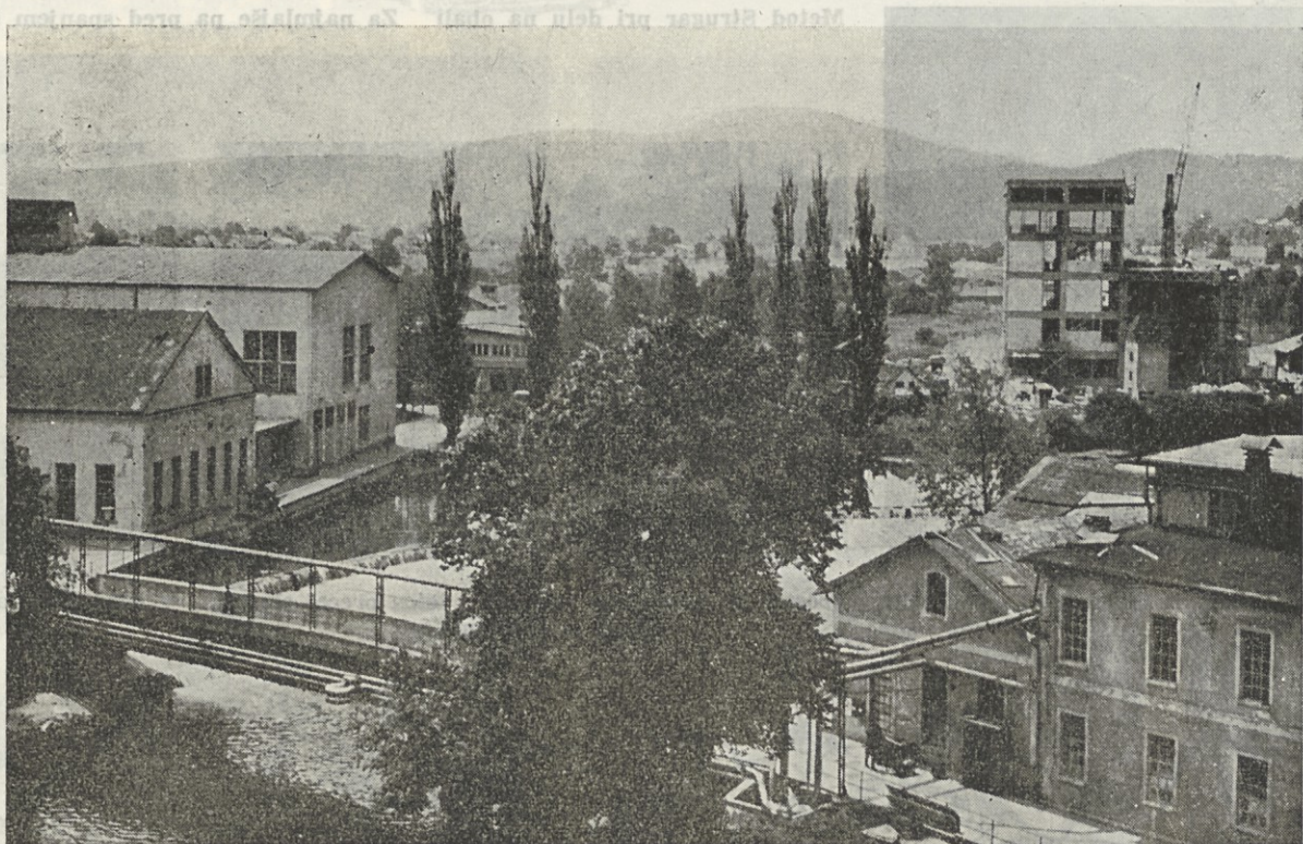
Zgradbe tovarne so dobile novo članico, zgradbo premaznega stroja, ki je preoblikovala našo panoramo
