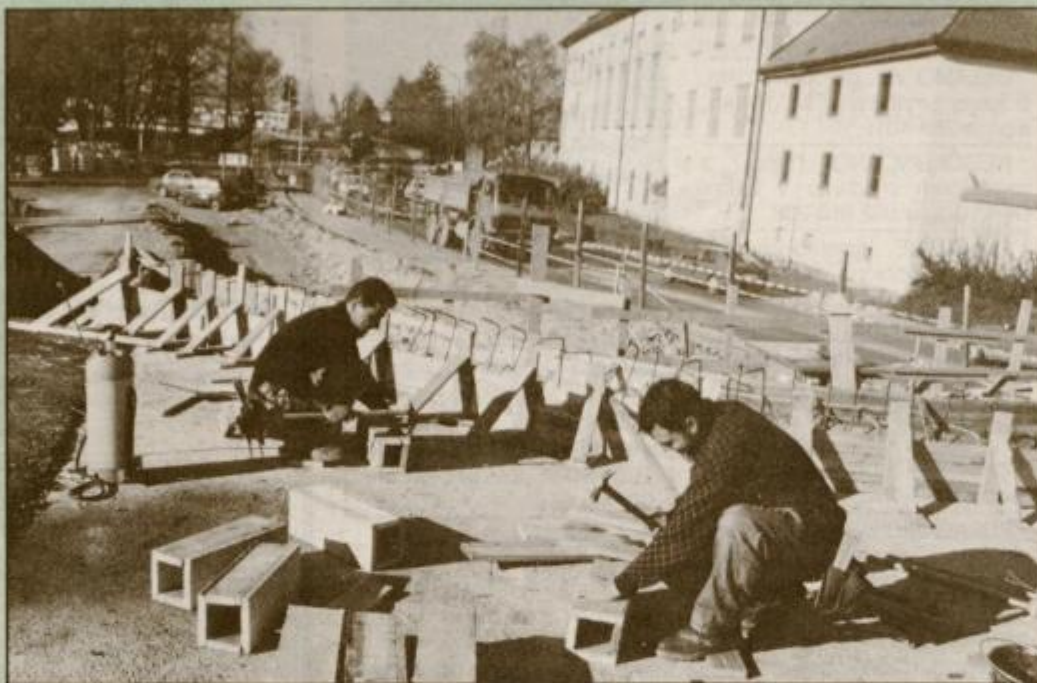
Pogled z nadvoza bodoče ceste, ki bo vodila čez železniški podvoz; v ozadju je viden priključek z mostu na podvoz.
