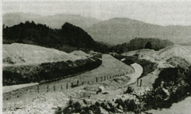
Nova struga Nevljice, zgrajena leta 1938, je izboljšala odvodnjavanje in preprečila izpodjedanje brežin pod pokopališčem in cerkvijo v Nevljah. Ogromni kupi gramoza kažejo, za kako obsežno delo je pri regulaciji šlo. (Foto: ga. V. Božič-Bernot)
