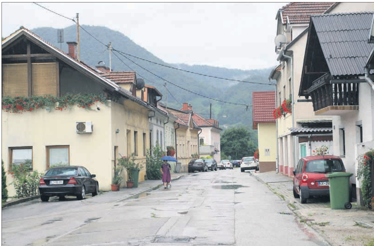
Breg bo končno dočakal lepšo podobo in razvoj. Krpanka bo postala asfaltirana cesta, ulico bo razsvetljevala sodobna javna razsvetljava, nova bo kanalizacija ...
