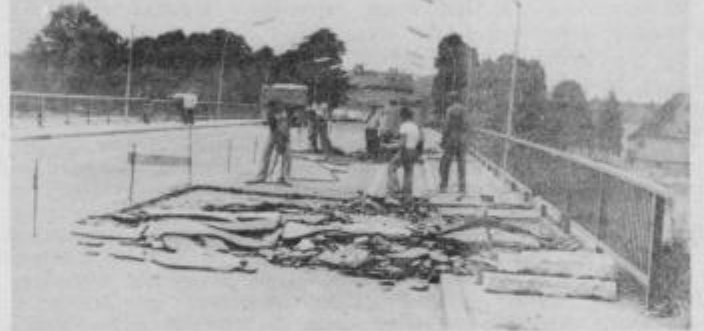
Delavci pri odstranjevanju dotrajane plasti asfalta foto: Danilo Klajnshek
