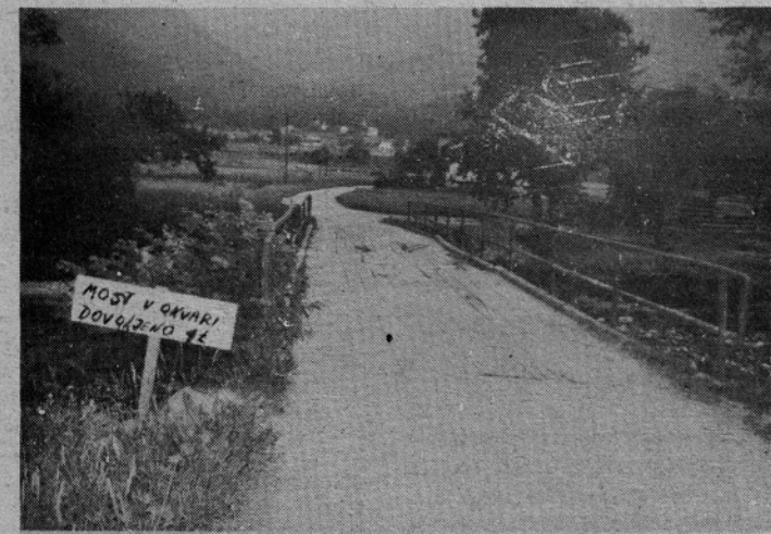
Mnoge mostove obnavljamo, mnogi so po poplavi utrpeli še več škode, med drugim tudi mostova v Bočni.
