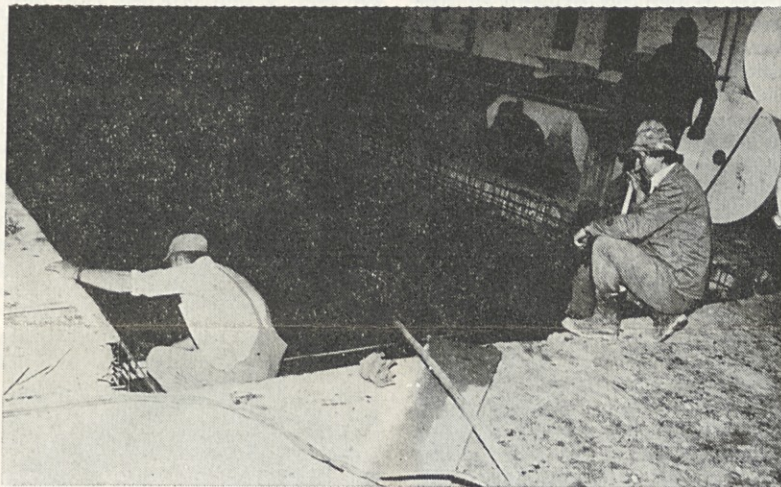
Med desetdnevno remontom je bilo treba narediti tudi novo osnovo za vzdolžni rezalni stroj v dodelavi petega papirnega stroja
