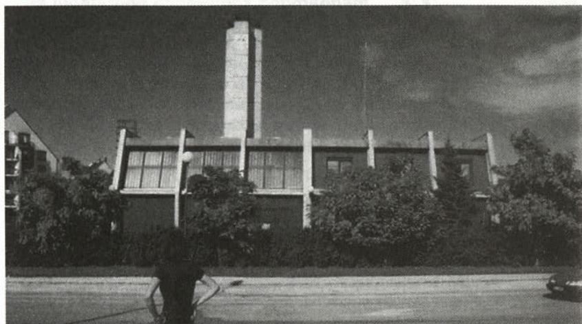
Energetski objekt kotlovnica, Volkmerjeva c. 20, Ptuj
