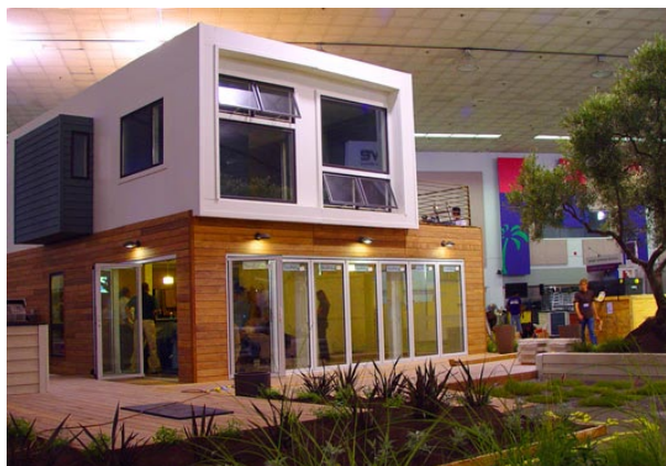
■ Slika 2. SG Blocks, Harbinger House, Lawrence Group - The Build, stanovanjska hiša iz odpadnih zabojnikov
